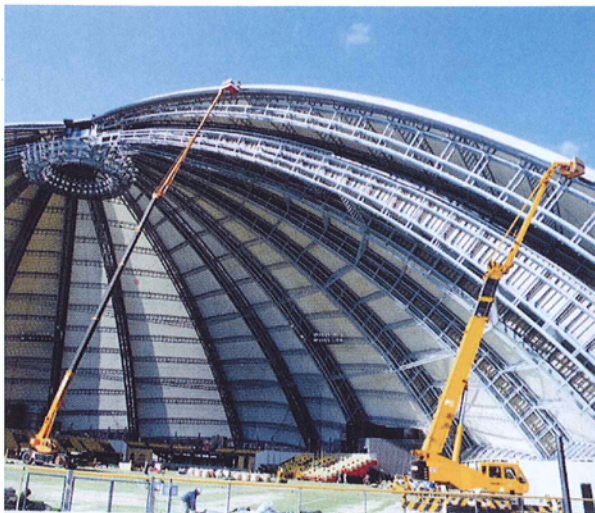
ドーム塗装 55m作業 50Tラフター
